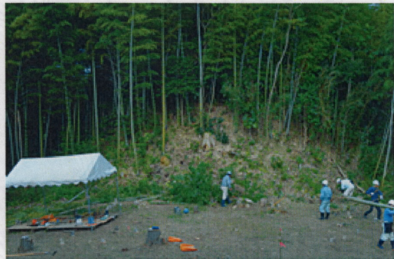
2号墳調査前(西から)
